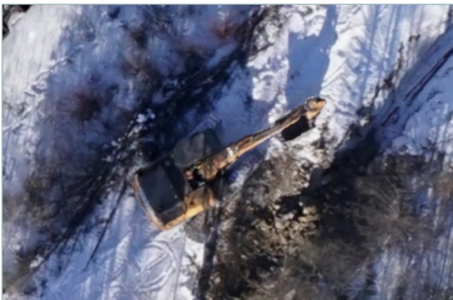
Экскаватор на Дальневосточной железной дороге 7 ноября 2022 г. / An excavator on the Far Eastern Railway on November 7, 2022
